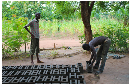
Fabrication des parpaings pour l'école
